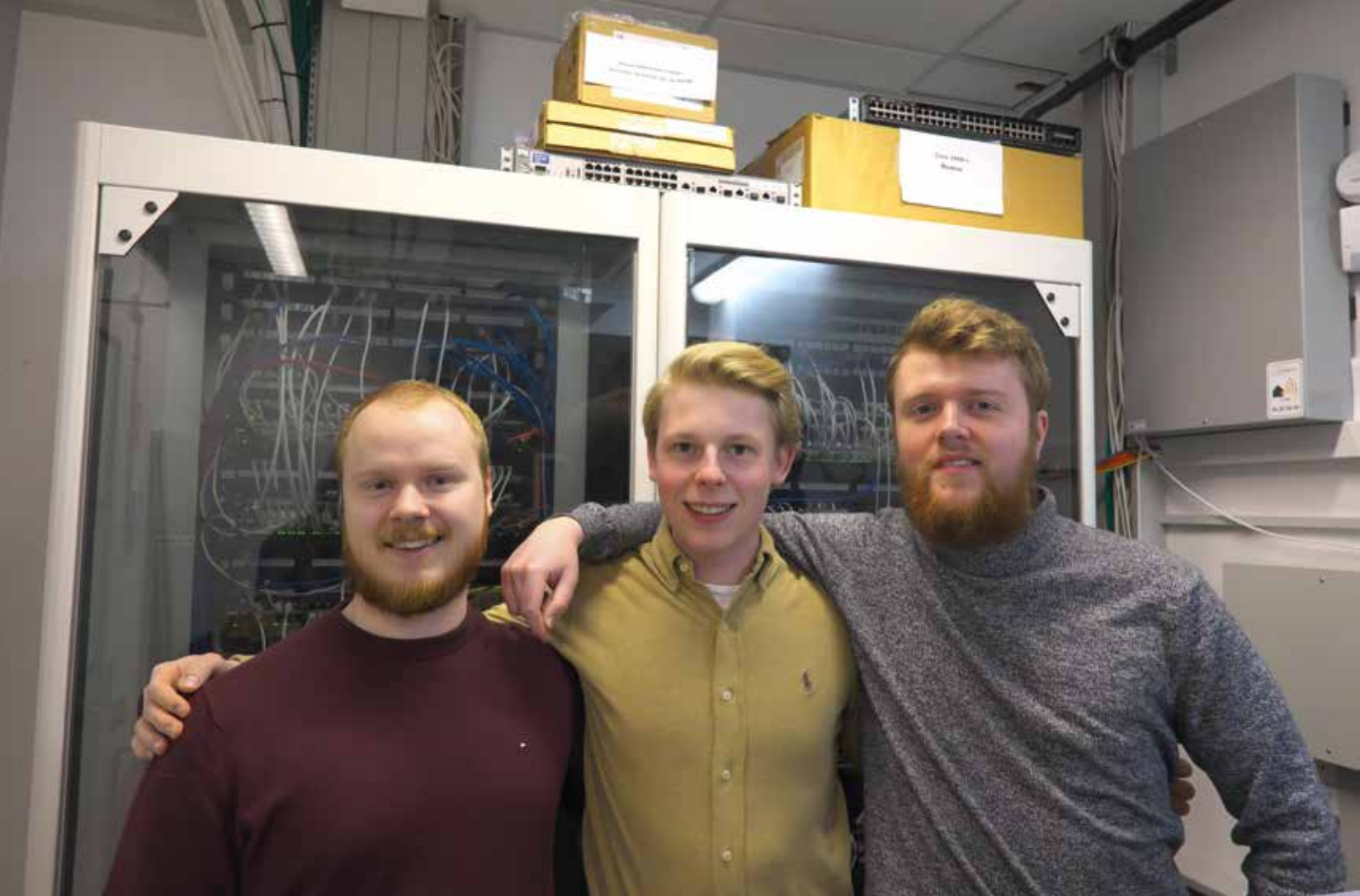
Mathias, Mikkel og Julius i virksomhedens centrale serverrum.
