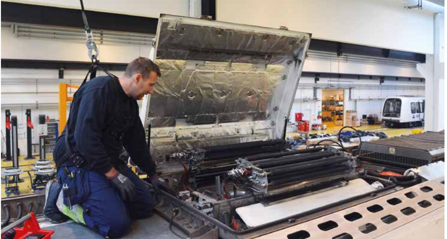
► Metrotekniker Kristian Fuldbj-Johansen renser ventilationssystemet. "Der er meget støv i en tunnel, og det skal vi sørge for, at passagererne ikke indånder". Han er uddannet flymekaniker og var 9 år i DSB, før han blev metrotekniker.
