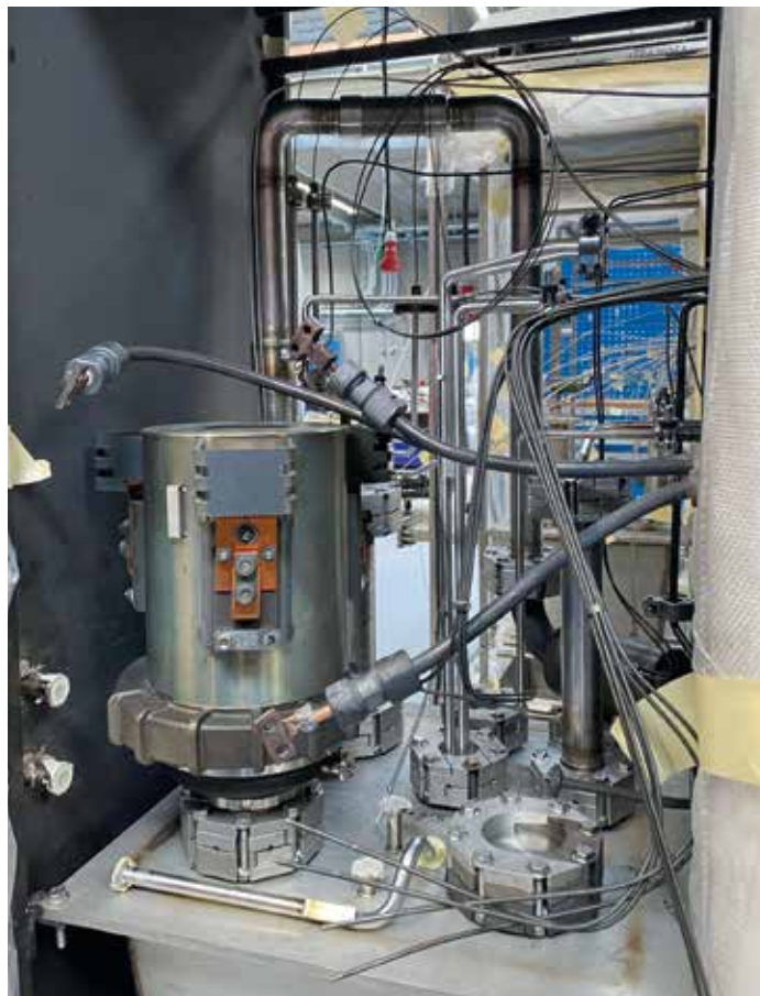
► Et test loop under opbygning – Det hele bliver samlet og testet i Danmark. Alle de forskellige dele skal spille fejlfrit sammen, og når de gør det, bliver der frigivet store mængder energi.
